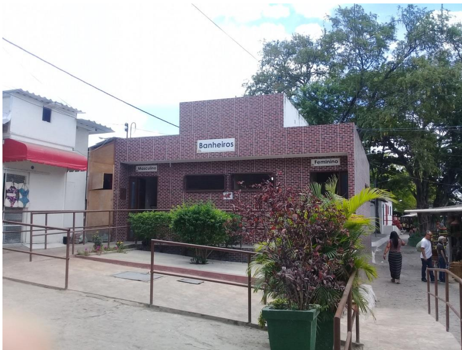
Novas instalações hidro-sanitárias.
