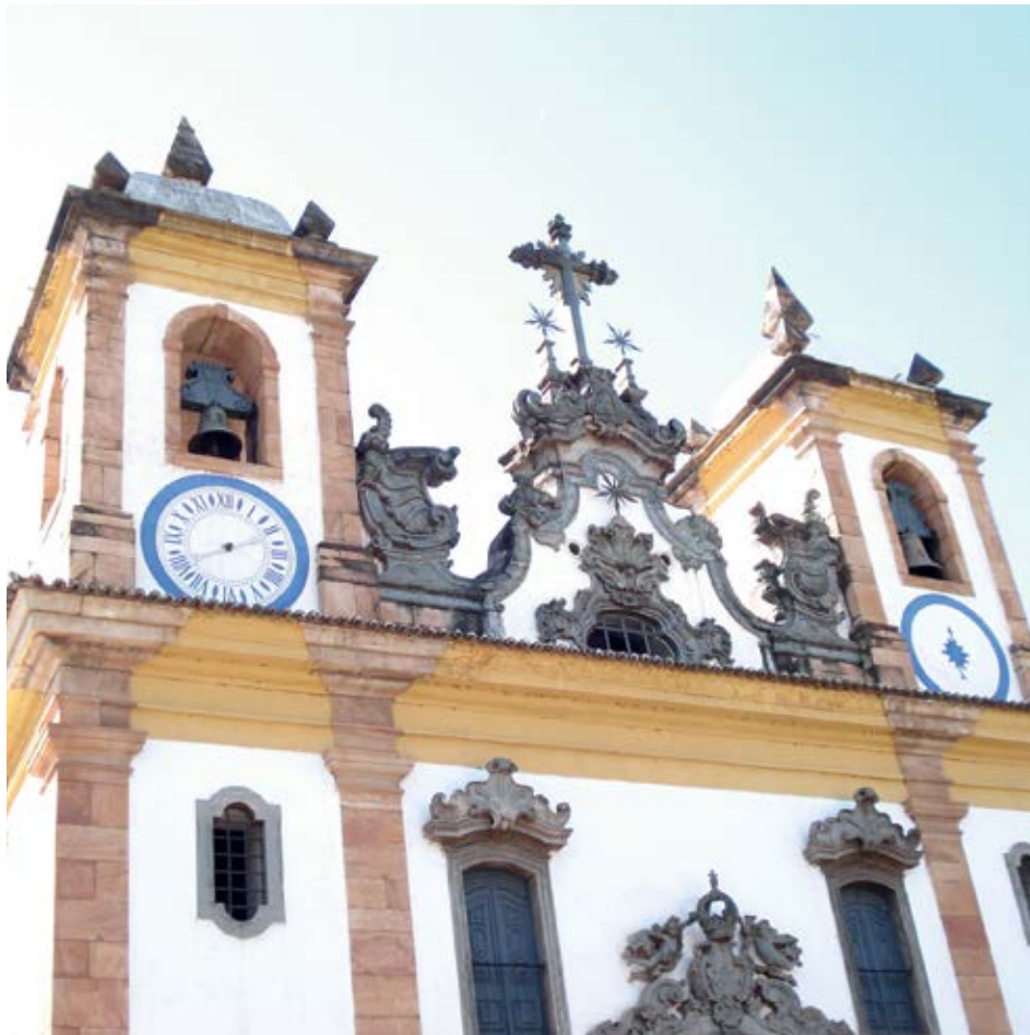
VISTA PARCIAL DA IGREJA NOSSA SENHORA DO CARMO, SABARÁ.
